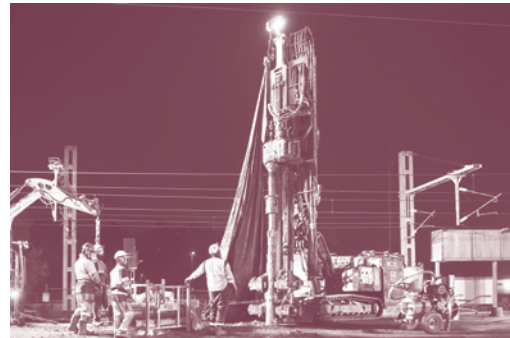
Pose des pieux de la future passerelle
