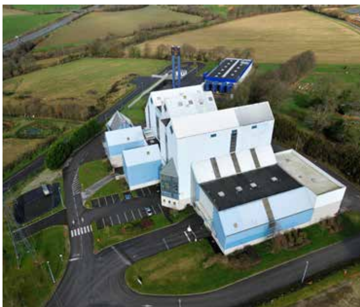
L'Unité de valorisation énergétique des déchets située à Briec.
