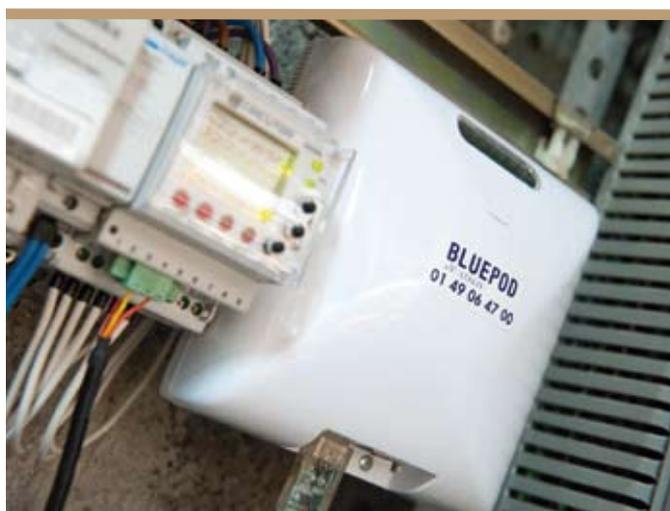
**PLAN CLIMAT** | Quimper Communauté soutient l'installation de boîtiers sur les tableaux électriques des particuliers ou des bâtiments publics. L'objectif ? Soulager le réseau pour éviter des coupures en période hivernale. Le « BluePod », conçu par la société Voltalis, permet également de faire des économies sur la facture électrique.
