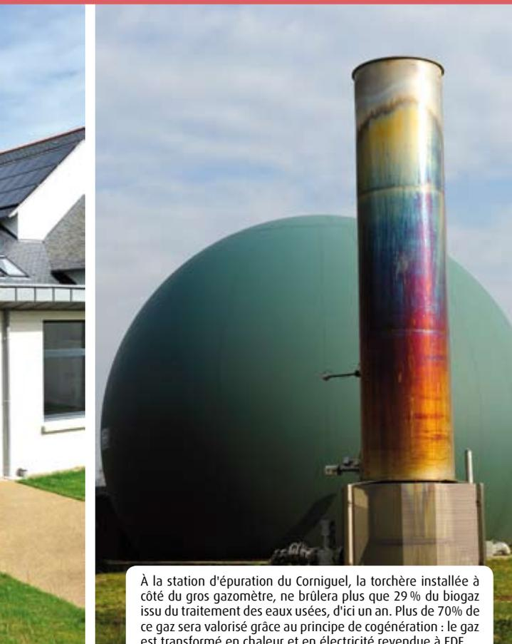
À la station d'épuration du Corniguel, la torchère installée à côté du gros gazomètre, ne brûlera plus que 29 % du biogaz issu du traitement des eaux usées, d'ici un an. Plus de 70% de ce gaz sera valorisé grâce au principe de cogénération : le gaz est transformé en chaleur et en électricité revendue à EDF.
